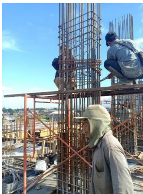
Gambar 2. 1 Pemasangan tulangan pada kolom
